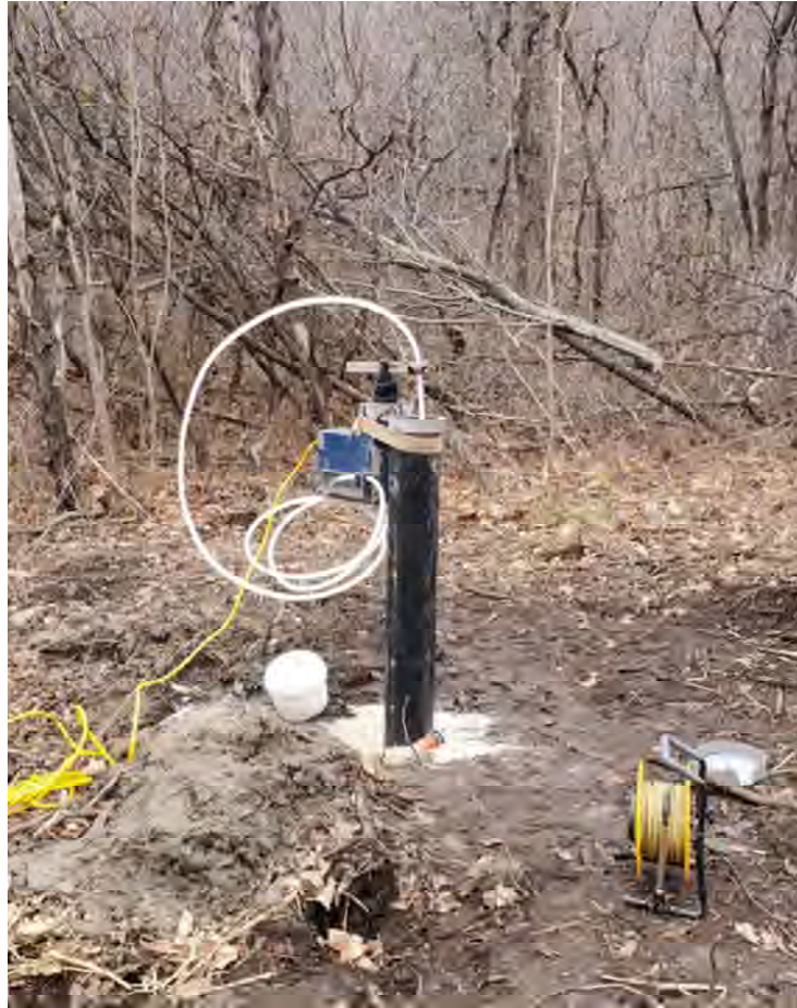
Photo 5 Développement du puits 20-PO09
