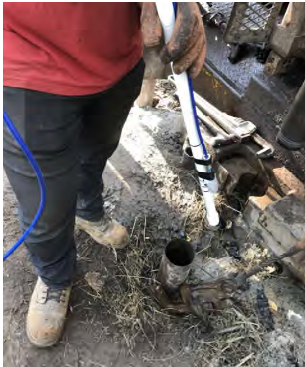
Photo 4 Installation du piézomètre à corde vibrante 20-PZ26
